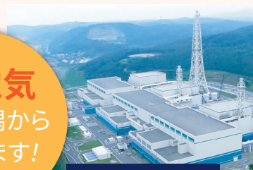
柏崎刈羽原子力発電所
